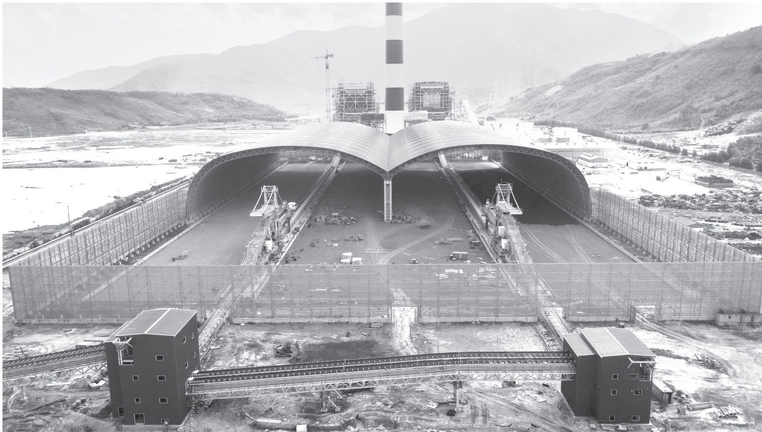
Dự án Nhà máy Nhiệt điện Quảng Trạch I đang đẩy nhanh tiến độ để phát điện theo kế hoạch
