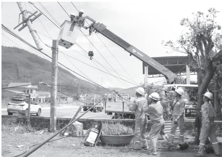
Các kỹ sư, công nhân EVNCPC khẩn trương khôi phục hệ thống lưới điện bị sự cố do bão số 10 tại khu vực phía Bắc tỉnh Quảng Trị - Ảnh: V.M
